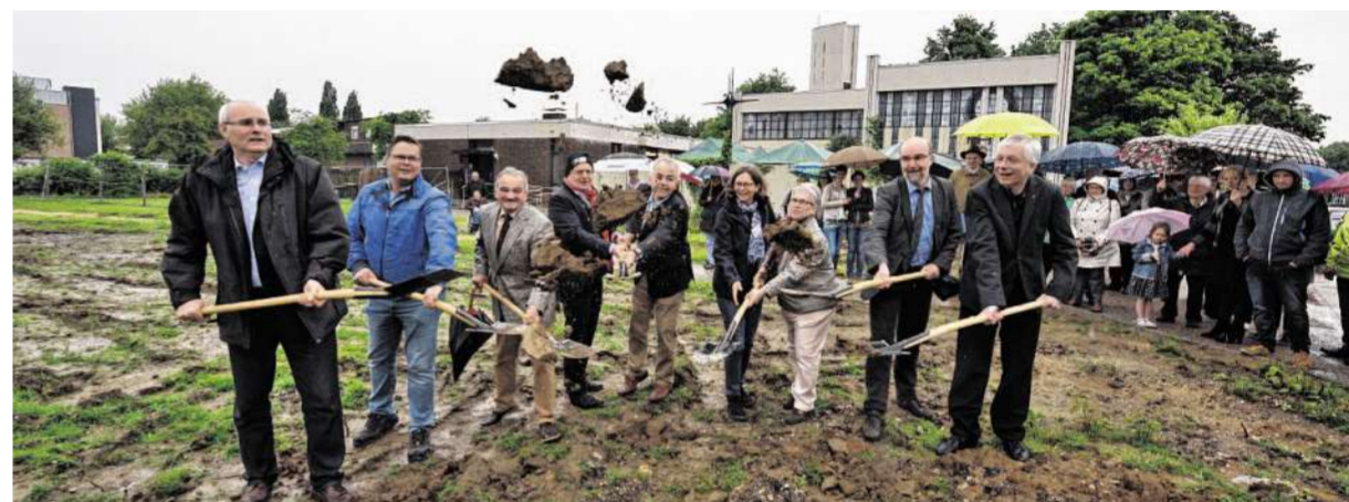
Hanno Frenken, Geschäftsführer der Franziskusheim gGmbH (links), Architekt Josef Viethen (Mitte), Leo Kuhn (3. von links), stellvertretender Bürgermeister, und Pastor Peter Frisch (rechts) beim Spatenstich.
