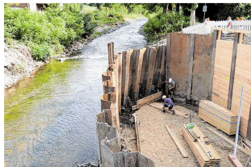
Derzeit werden die Fundamente für die neue Wurmbrücke bei Burg Trips gelegt. Die neue Brücke soll Ende Oktober aufgesetzt werden.
