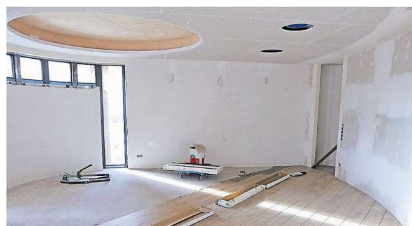
Der Sakralraum ist ein Ersatz für die Pfarrkirche St. Josef, die abgerissen wurde. Hier werden noch Glasfenster aus dem ehemaligen Gotteshaus eingebaut.
