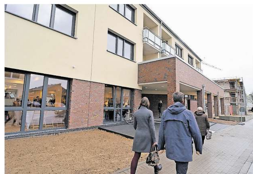
Der erste Baukomplex des Quartierszentrums Bauchem wurde eröffnet. Der zweite Bauabschnitt entsteht bis Ende 2019.
