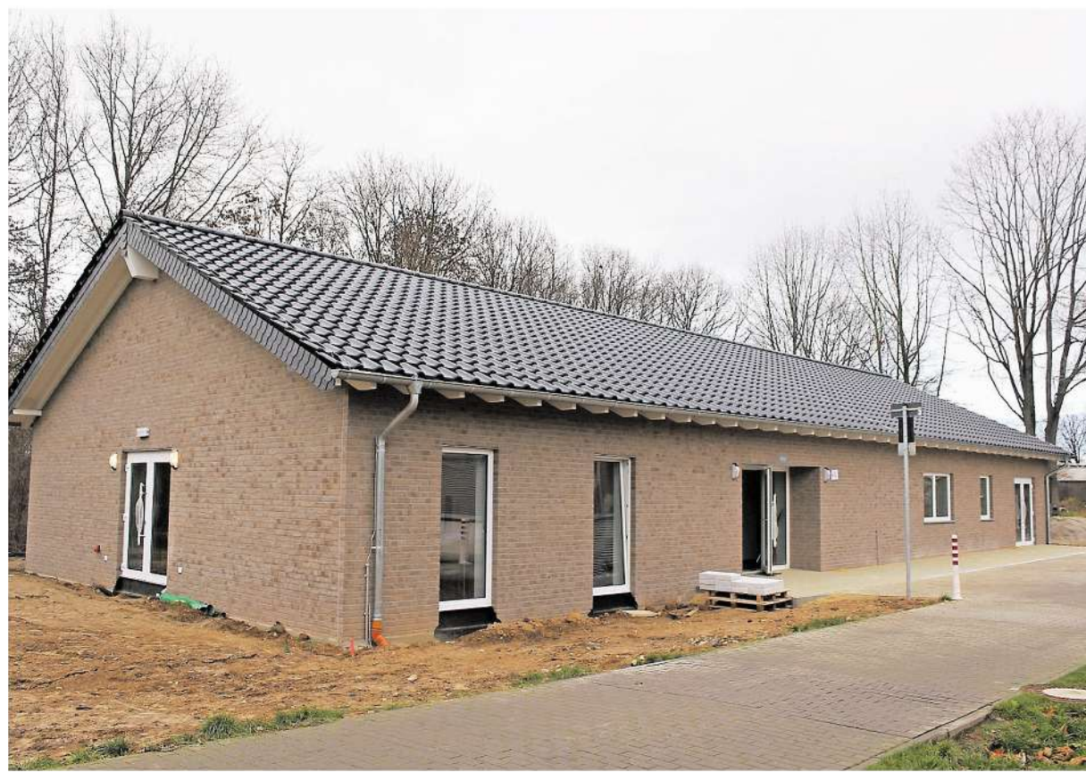
Ein Jahr nach dem Spatenstich ist das Bürgerhaus fertiggestellt.
