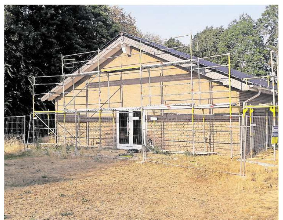
Ein Bild aus der Bauphase.
